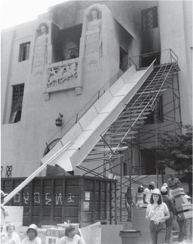
Un tobogán improvisado ayuda a remover los escombros después del devastador incendio de 1986. (Institutional Collection)
